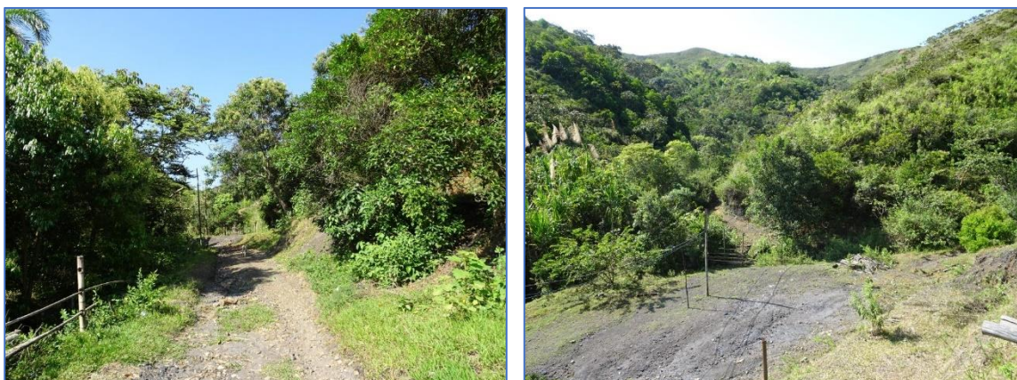
Fotos N°15 y 16. Vía de acceso a la mina El Palmar. Vista del área de acopio de la mina prospectada en ladera de montaña cortada y adecuada.
