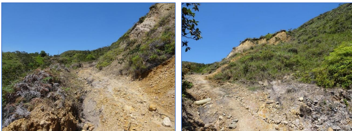
Fotos N°35 y 36. Caminos abiertos con materiales rocosos en superficie y en las laderas.
