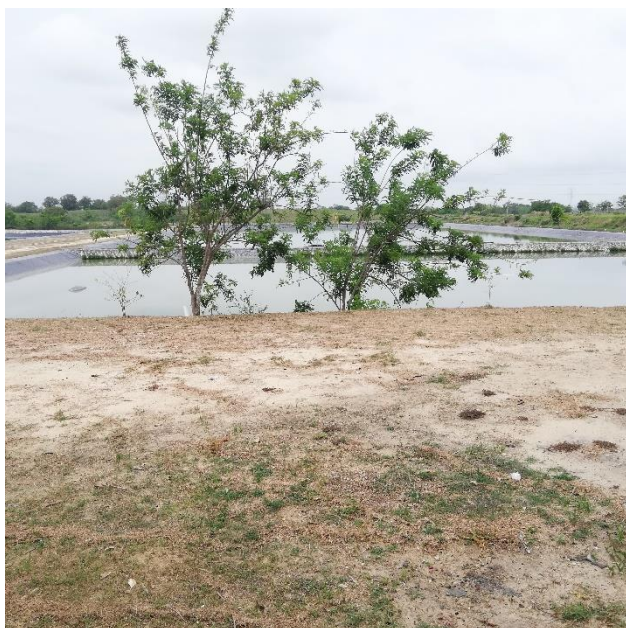
Foto 3 Planta de tratamiento de aguas negras de Baranoa, a escasos 30 metros del área de influencia directa del proyecto.
