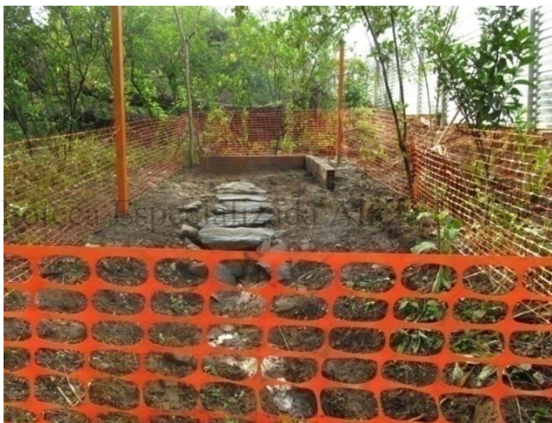
Foto 30. Estructura de paso sobre un sector de pantano, al final del mantenimiento e instalación de la malla de protección que delimita el área cautelada para conservación.
