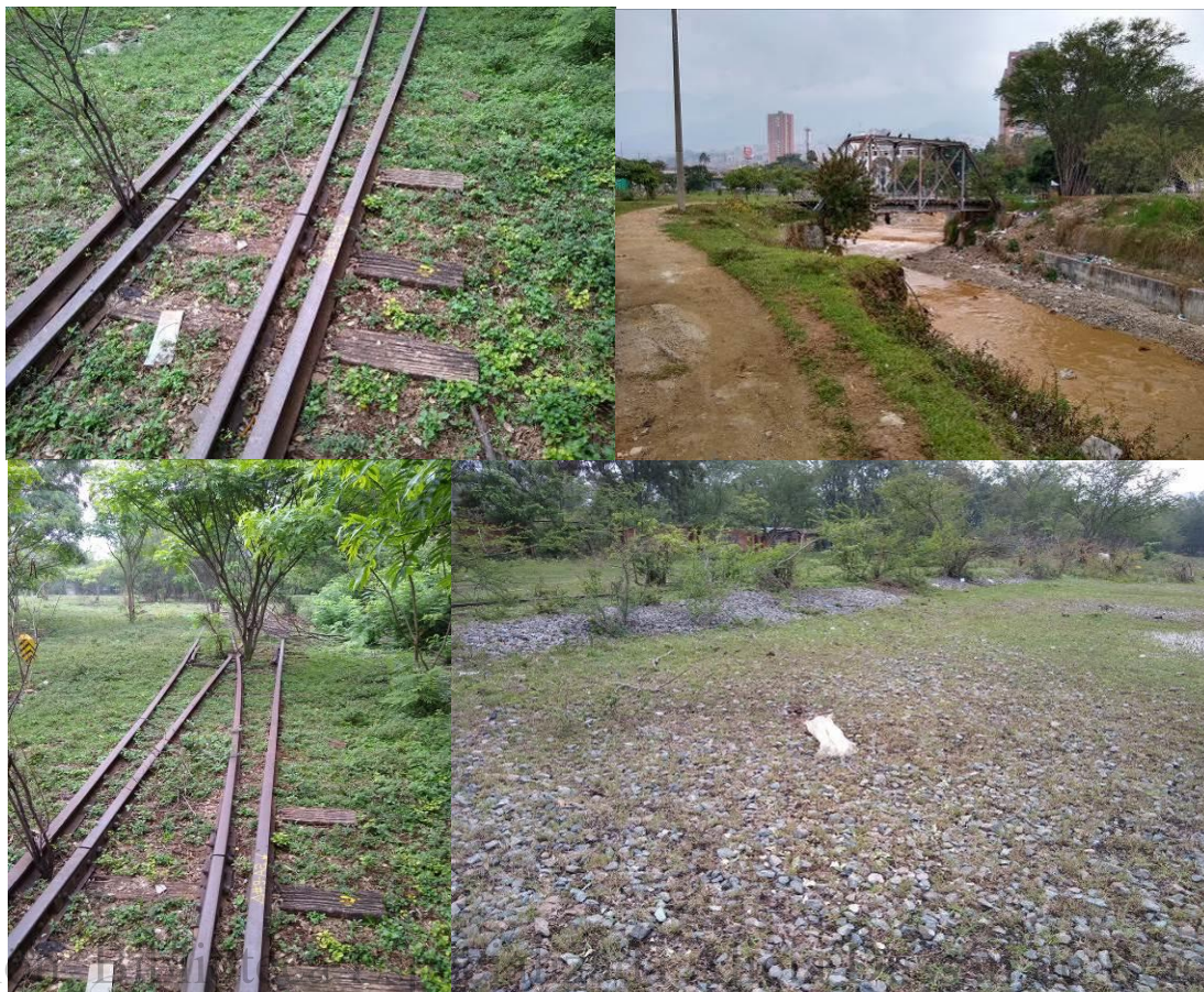
Fotos 71, 72, 73 y 74. Puente del Antiguo Ferrocarril de Antioquia que cruza la quebrada La García y línea Férrea de rieles en hierro y polines en madera de comino cresco en tramos del terreno. Algunos tramos de los rieles están apoyados sobre camellones de grava.
