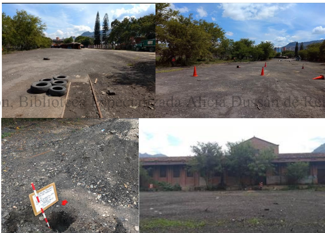
Fotos 139, 140, 141 y 142. Intervención por afirmado en Lote 5.
