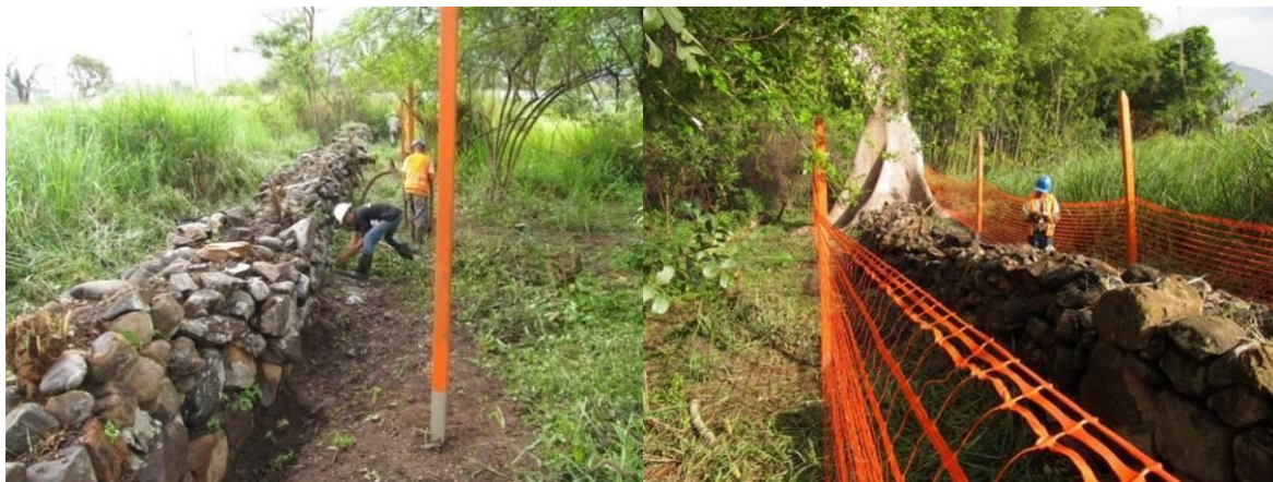
Fotos 28 y 79. Muro 2 – Norte, durante y al final del mantenimiento e instalación de la malla de protección que delimita el área cautelada para conservación.
