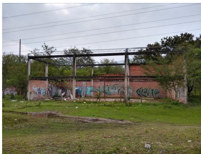
Foto 75. Estructuras recientes abandonadas con loza de concreto y mampostería de ladrillo.
