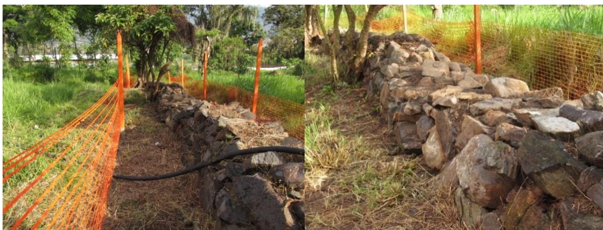
Fotos 26 y 27. Muro 1 – Sur, al final del mantenimiento e instalación de la malla de protección que delimita el área cautelada para conservación.
