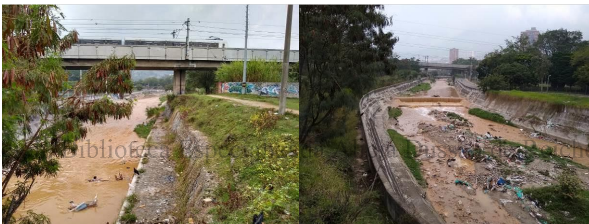
Fotos 78 y 79. Canalización en concreto de la quebrada La García.
