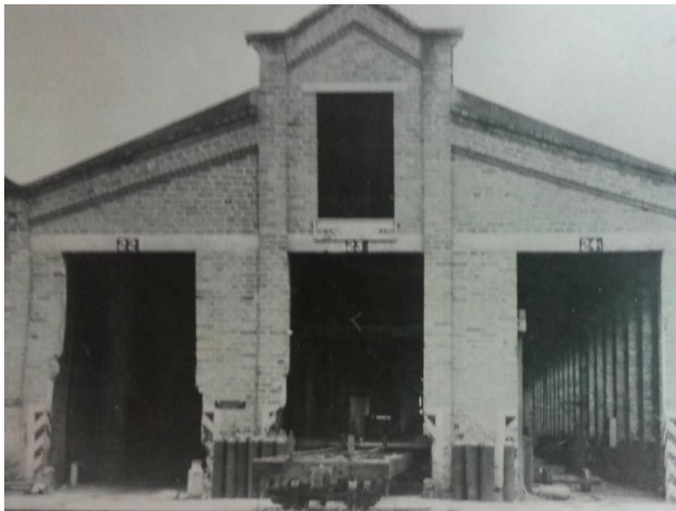
Foto 50. Talleres del Ferrocarril construido en ladrillo. El tamaño de los portones fue diseñado para el ingreso de los vagones. Fuente: Aguirre et.al., 1993.
