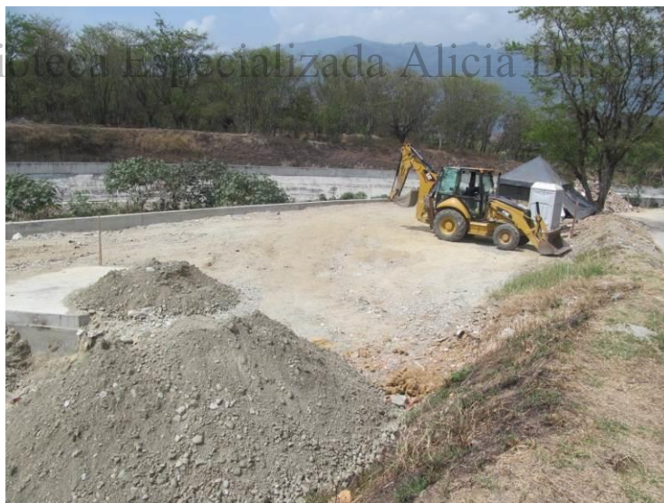
Foto 36. Ubicación del PC 24 en la margen izquierda (norte) de la quebrada La García.
