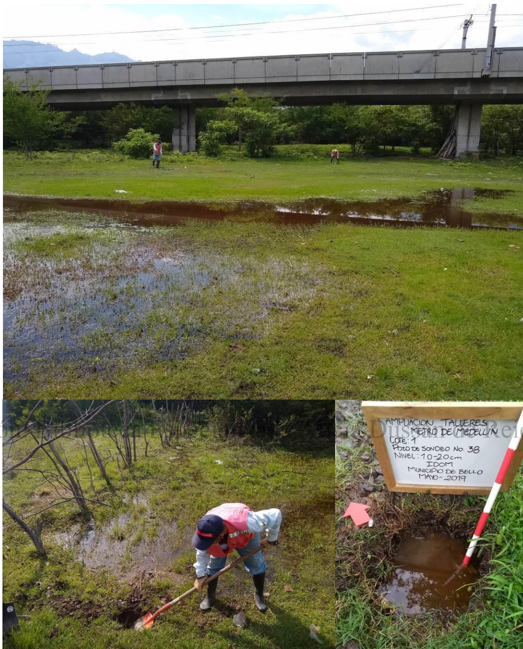
Fotos 105, 106 y 107. Zonas anegadas en cercanías al viaducto del Metro de Medellín.
