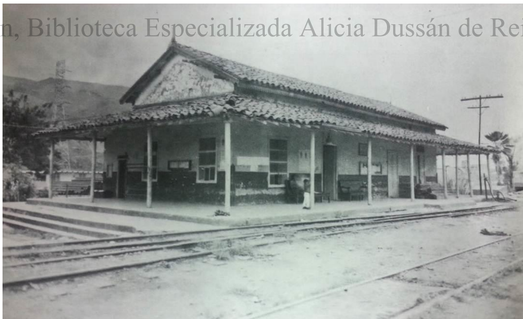
Foto 49. Antigua Estación Bello del Ferrocarril. La edificación fue demolida. Fuente: Aguirre et.al., 1993.
