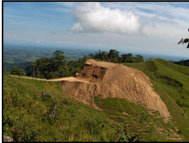
Foto 4.2 Cortes de tierra sobre la vía de acceso (préstamo de material), sin evidencias arqueológicas.
