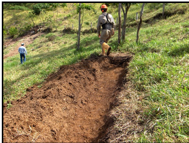
Foto 4.3 Revisión de la excavación de zanjas alrededor de la locación.
