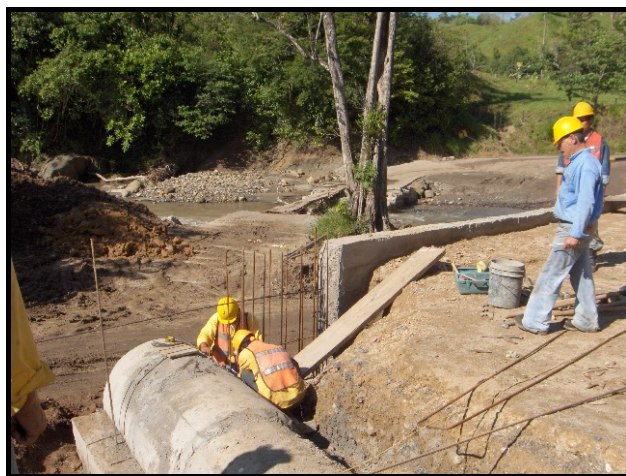
Foto 2.3 Obras civiles (puente sobre río Cáceres)
