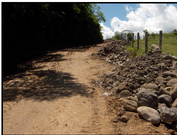
Foto 4.1 Adecuación de la vía existente
