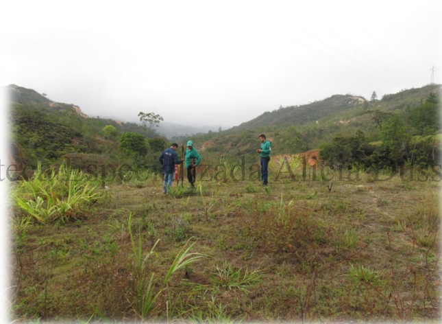
Fotografía 17. Punto específico de la torre 49, descartado por afloramiento de material rocoso. Se intentó la realización de dos pozos de sondeo, pero en ambos casos, a escasos 2 o 3 centímetros de profundidad aflora el material rocoso parental. Coordenadas 1080433 1415188
