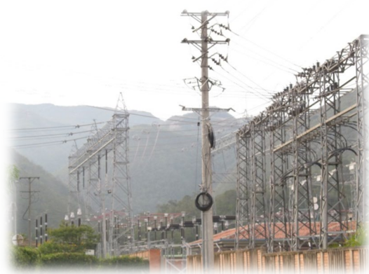
Fotografía 19. Área alterada al interior de la Subestación Eléctrica Ocaña.
