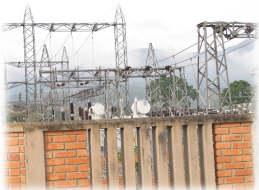
Fotografía 18. Área alterada al interior de la Subestación Eléctrica Ocaña.
