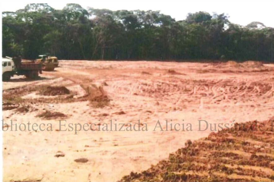
Foto 6. Panorámica área aplanada locación Cohembí 4
