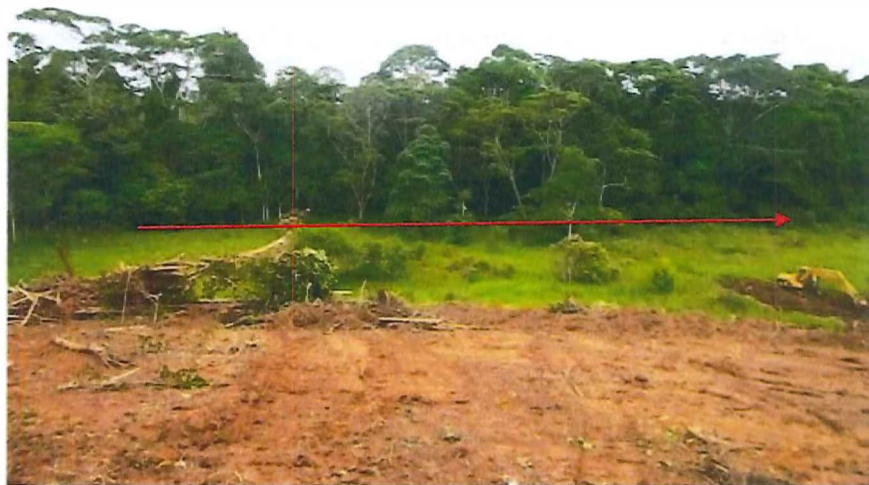
Foto 4. Proceso de descapote en la locación Cohembí 4. La flecha indica el cauce del río Lorenzo
