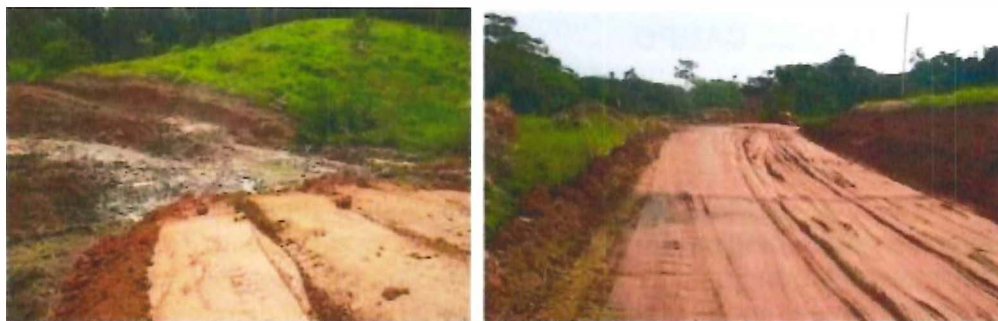
Foto 5. Detalle de las actividades de relleno en la locación Cohembí 4 para la vía de acceso.
