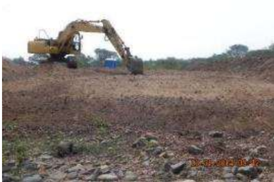
Foto 4. Acompañamiento al descapote realizado por la maquinaria de la obra.
