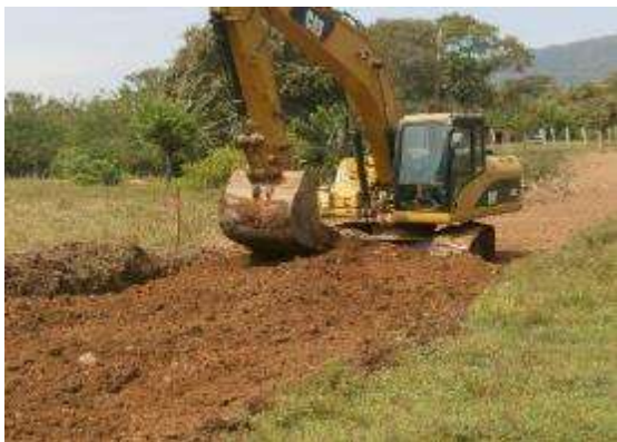
Foto 8. Acompañamiento al descapote realizado por la maquinaria de la obra.
