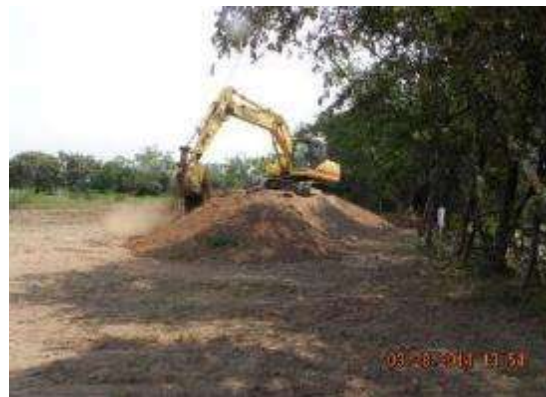
Foto 9. Monitoreo arqueológico en la realización de piscinas de lodos.
