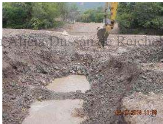
Foto 7. Monitoreo arqueológico en la adecuación del terreno para extender la tubería
