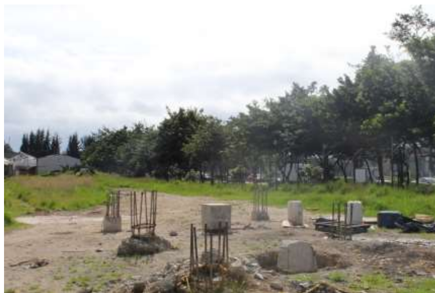
Figura 23. Registro fotográfico de una sección del área de estudio donde se observa la presencia de estructuras de cimentación.
