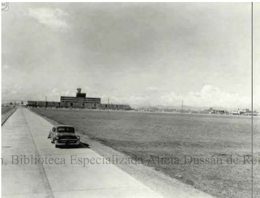
Figura 16. Fotografía de la Avenida El Dorado. Al fondo la torre del Aeropuerto.1.960
