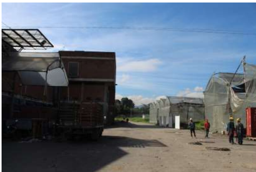
Figura 22. Panorámica del ingreso al área de estudio donde se observa la presencia de zonas con construcciones modernas (bodegas).
