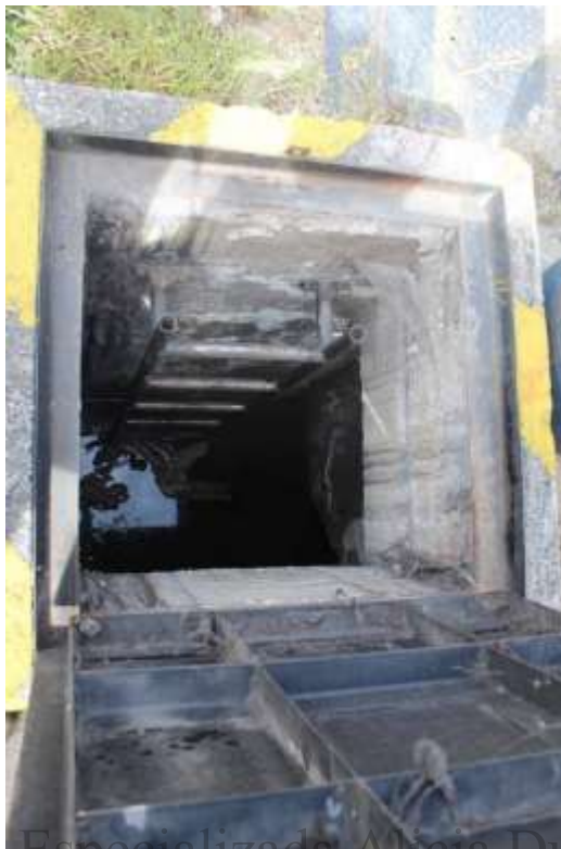
Figura 24. Panorámica del ingreso al área de estudio donde se observa la presencia de tanques de almacenamiento de agua a una profundidad de hasta 4 metros.
