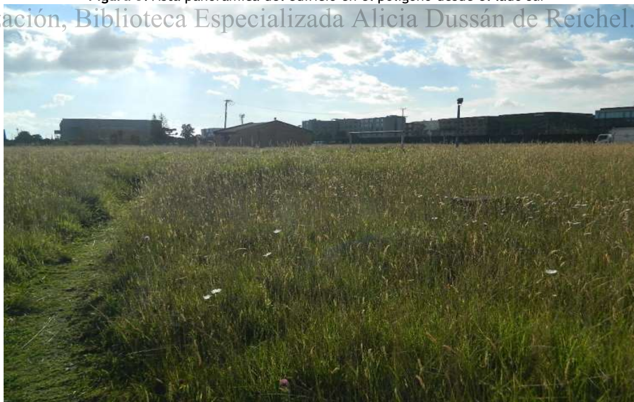
Figura 5. Vista panorámica del edificio en el polígono desde el lado sur
