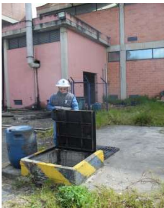
Figura 25. Panorámica del ingreso al área de estudio donde se observa la presencia de tanques de almacenamiento de agua a una profundidad de hasta 4 metros.
