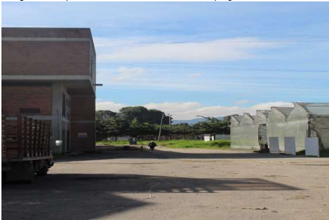
Figura 6. Vista panorámica de las zonas asfaltadas en el polígono desde el lado norte
