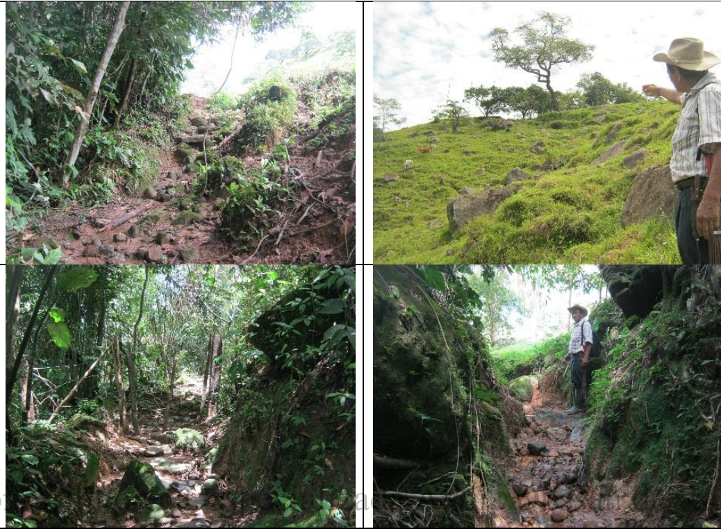
CAMINO ANTIGUO HACIA EL ALTO DE VANEGAS, CON PRESENCIA DEL CAMELLÓN Y EMPEDRADO INTERVENIDO Fuente: Campo 2016
