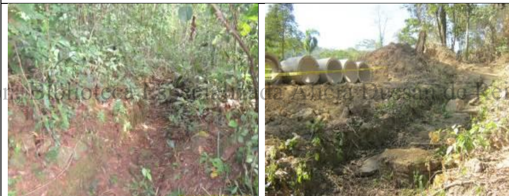
RETIRO Y ACOPIO DE LAS PIEDRAS DEL CAMINO ANTIGUO HACIA LA MARGEN DE LA OBRA. TOMADA DE CHACÍN - 2013.
