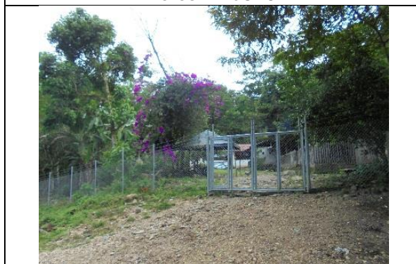
ANTIGUA CHICHERÍA, HOY VIVIENDA MODERNA. FUENTE CAMPO 2016
