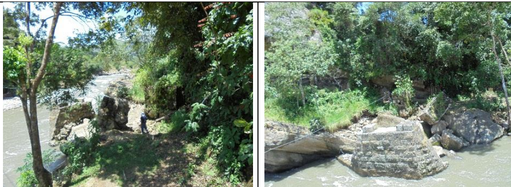
BASES (ESTRIBOS) DEL PUENTE ANTIGUO SOBRE EL RÍO PAYERO. PASO OBLIGADO HACIA NUNCHÍA. FUENTE: CAMPO 2016
