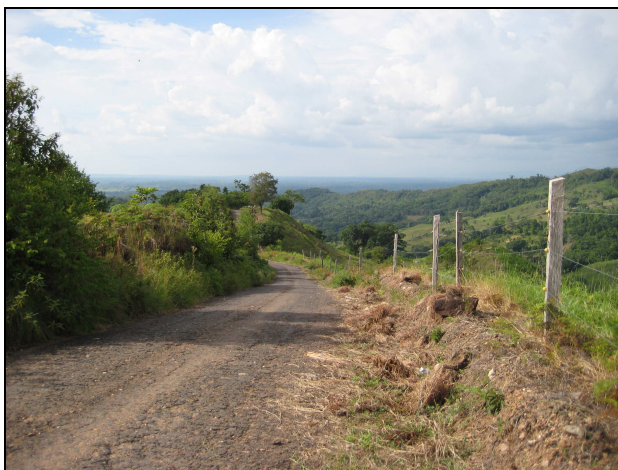
FOTOGRAFÍA 9 VÍA DE ACCESO EXISTENTE
