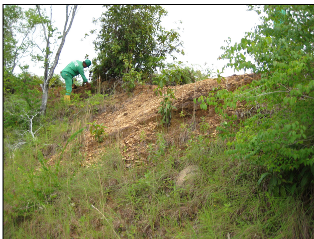
FOTOGRAFÍA 13 REVISIÓN DE SECTORES ALEDAÑOS A LA VÍA DE ACCESO
