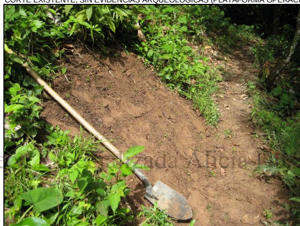
FOTOGRAFÍA 8 REVISION DE PERFIL EXISTENTE, JUNTO A LA PLATAFORMA DE OPERACIONES
