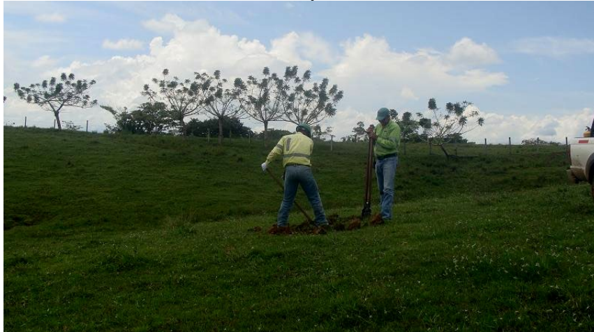
Foto 7-10 Proceso de excavación de un pozo de sondeo en el sector del Botón.
