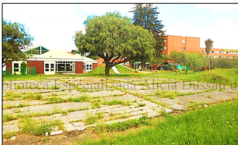
Figura 26. Placa en concreto de las antiguas aulas, al fondo, instalaciones del jardín
