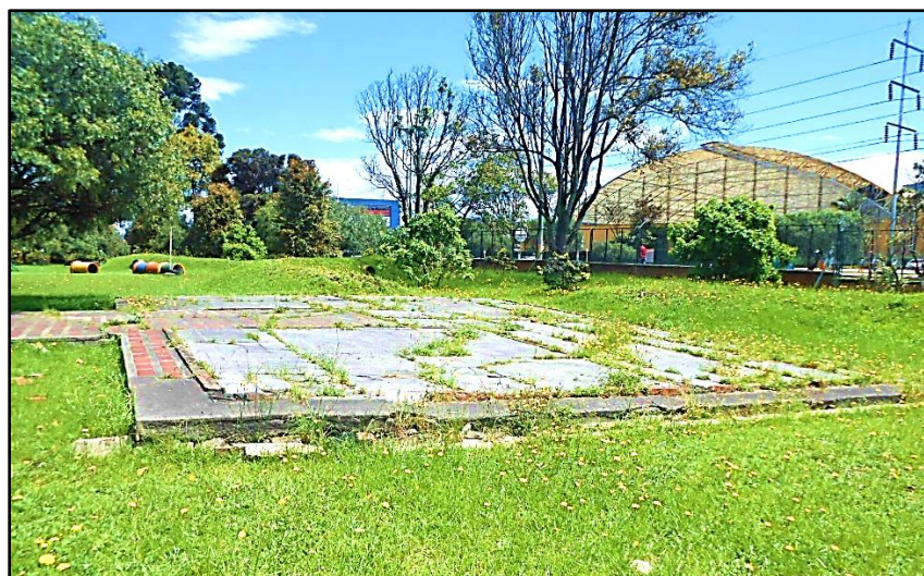
Figura 27. Placa en concreto de las antiguas aulas, vista lateral, dirección norte
