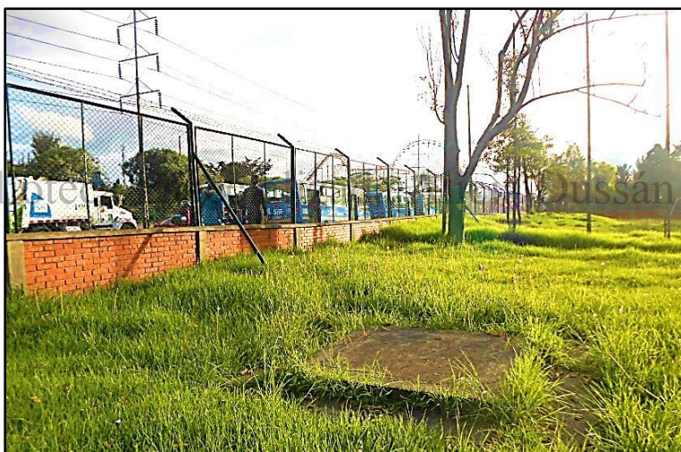
Figura 29. Tapa de alcantarilla, sector oriental.
