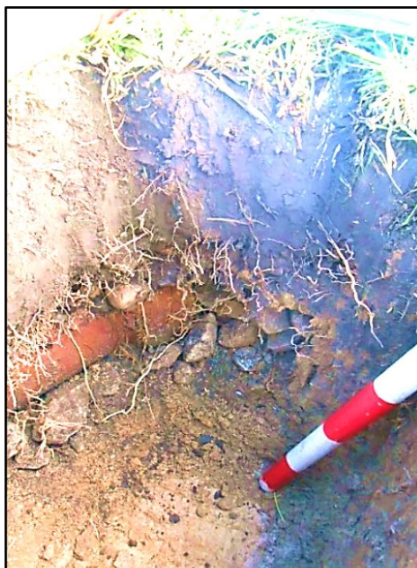
Figura 6. Tubo contemporáneo y relleno con piedra de río a 40 cm de profundidad. Pozo 45.
