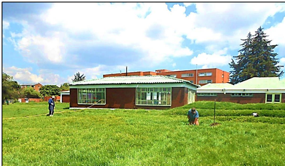
Figura 48. Proceso de apertura de los pozos de sondeo en el predio
