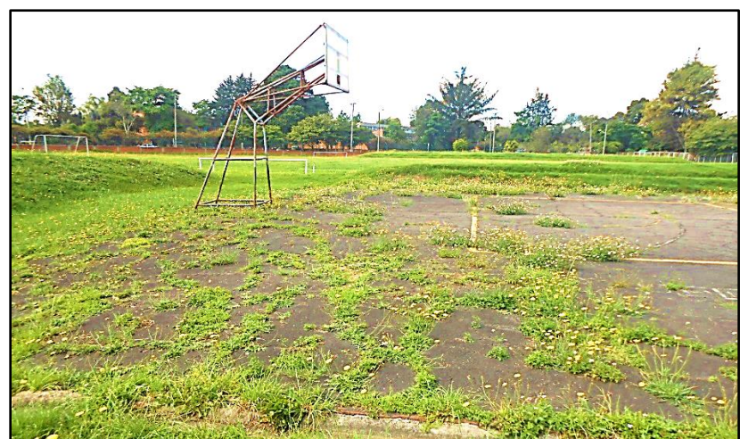
Figura 24. Cancha en asfalto, sector posterior del jardín infantil, vista lateral.
