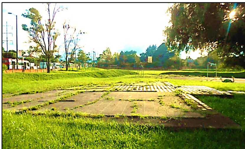
Figura 25. Placa en concreto de las antiguas aulas, vista lateral dirección sur.
