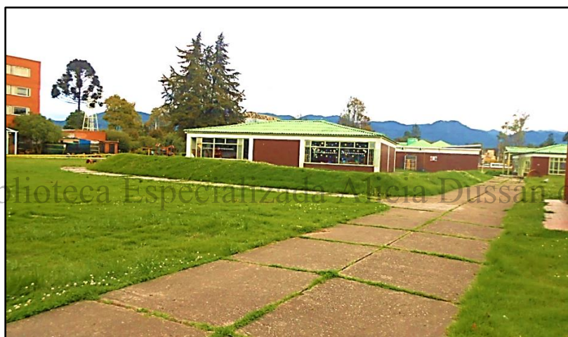
Figura 11. Vía peatonal de acceso a las instalaciones del Jardín Infantil
