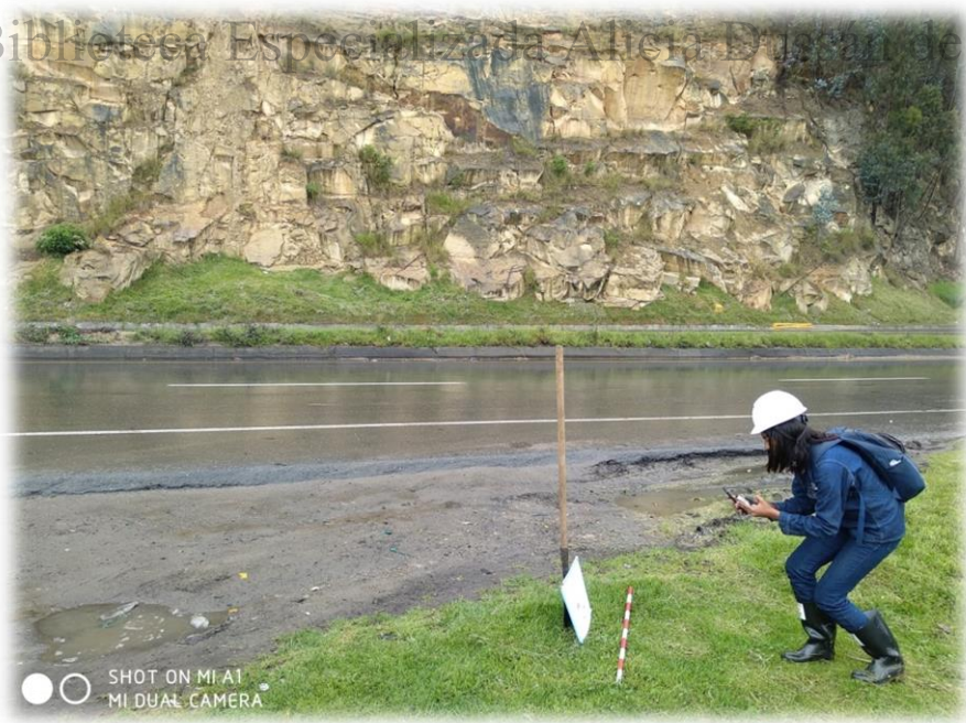
Fotografía 3. Puntos de registro proyectados sobre el mismo derecho de vía de la actual carretera.
