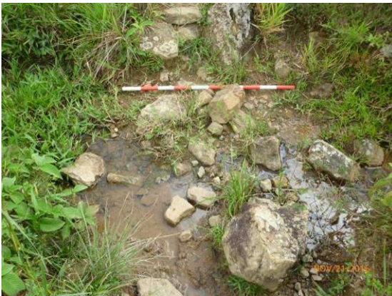
Fotografía 17. Sectores inundables y de escorrentía en las zonas más planas del ZODME 39.
