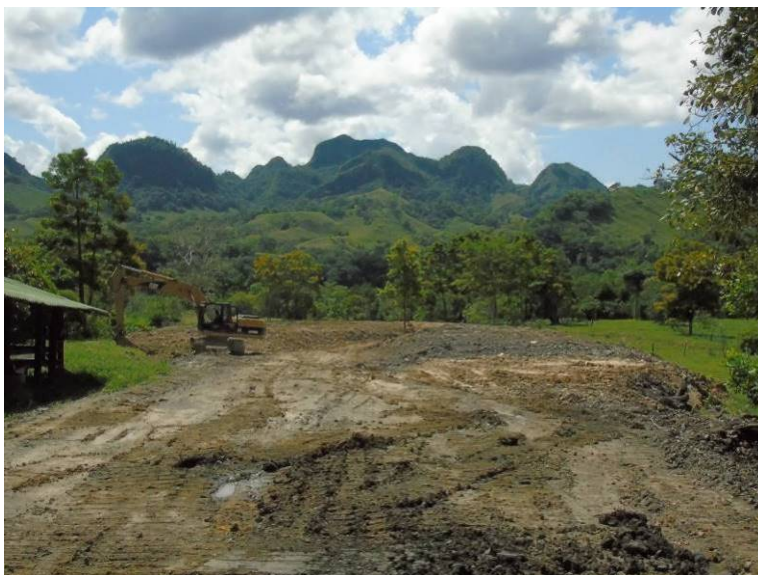
Fotografía 8. Zona intervenida mediante la acumulación de materiales foráneos de relleno en el extremo oriental del polígono.
