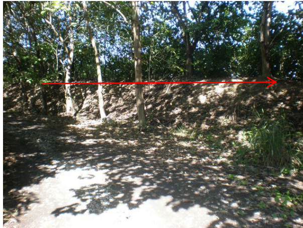
Fotografía 7-3 Panorámica del Jarillon que divide la zona de estudio con el patio de acopio actual (línea roja).
