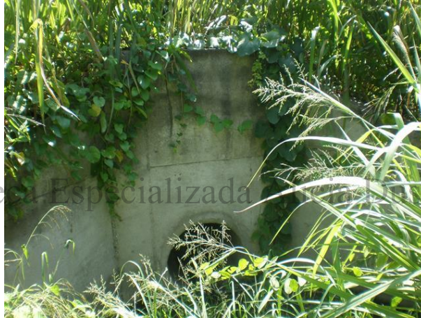
Fotografía 7-6 Detalle de alcantarilla en el costado oriental.
