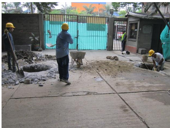
Foto 32. Excavación manual para nichos de pilas. Vista general de ubicación de dos nichos de forma circular para pilas en el polígono de intervención arqueológica, sector 2.
