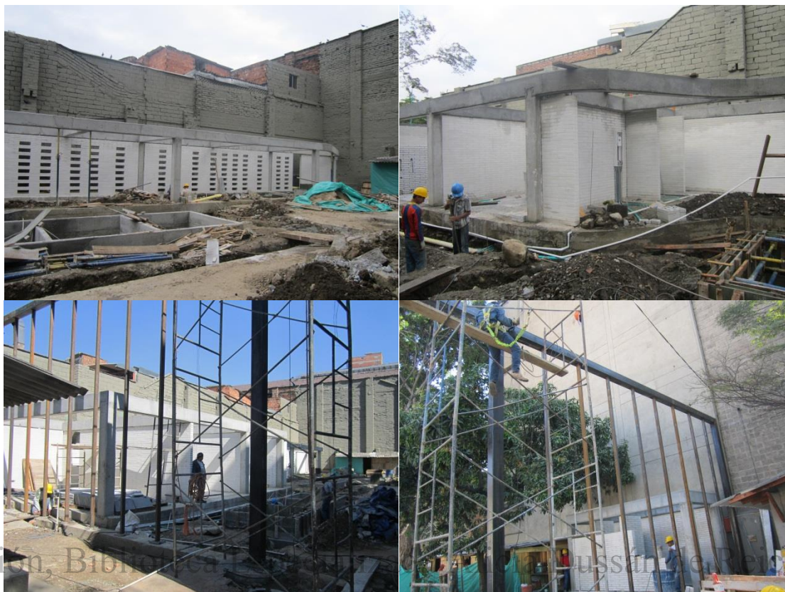
Fotos 101, 102, 103, 104, 105, 106, 107, 108, 109 y 110. Estado final de los dos sectores del predio del Proyecto Centro B- Punto Naranja- EMVARIAS después de concluir el desmonte de individuos arbóreos, retiro del borde en sardinel de dos de las jardineras, excavaciones manuales de brechas para instalaciones de redes y nichos para pilas y zapatas de las fundaciones del nuevo edificio.
