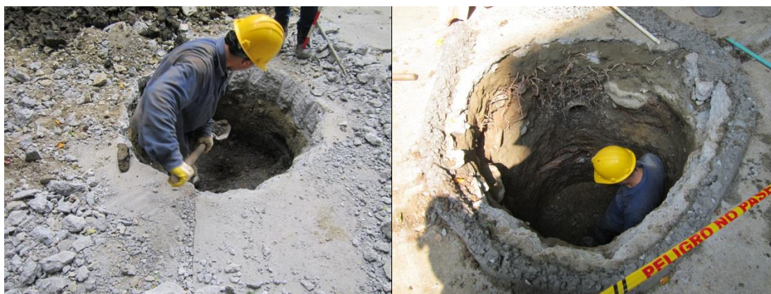
Fotos 96 y 97. Acompañamiento arqueológico a labores de excavación manual de nichos de pilas en las que se pudo controlar la intervención por niveles arbitrarios de 10 cm. Sector 2, sub-sector A. Superior: Proceso de excavación manual de nichos para pilas en estado inicial, Inferior: Proceso de excavación manual en estado final.
