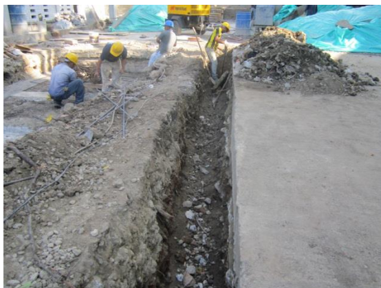
Foto 77. Acompañamiento arqueológico a excavación manual de brechas para instalación de las redes hidro-sanitarias, de gas y de energía eléctrica, Sector 2 sub-sector A.
