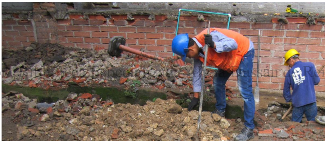
Foto 78. Revisión de material desalojado simultáneo a excavación manual de brechas para instalación de redes de gas, eléctricas e hidro-sanitarias, Sector 2 sub-sector A.
