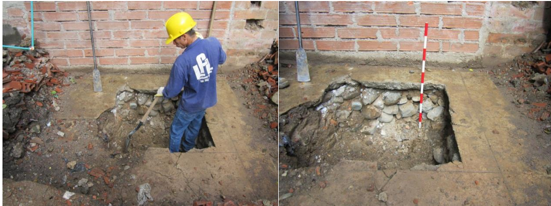
Fotos 28 y 29. Excavación manual de nichos para zapatas. Izquierda: Acompañamiento arqueológico a la excavación manual para nichos de zapatas. Derecha: Registro de niveles 1 (0-20 cm) y 2 (20-40 cm) en perfil estratigráfico visible tras excavación manual para nichos de zapatas.
