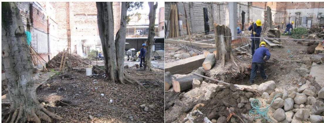
Fotos 18 y 19. Proceso de acompañamiento arqueológico en monitoreo. Derecha: Excavación manual para retirar capa con aporte orgánico y proceder al levantamiento de la estructura presente con maquinaria. Izquierda: Foto Panorámica de una de las jardineras del sector 1 que comenzó a ser intervenida por la obra.
