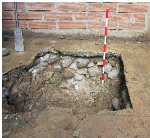
Foto 88. Perfil estratigráfico expuesto al comienzo de excavación manual de nichos para zapatas donde se observa una capa reciente de 42 cm de espesor aproximado (sub-base).
