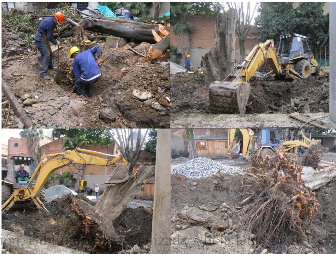
Fotos 51, 52, 53, 54, 55, 56 y 57. Proceso de triturado de sardineles en concreto (bordes de las jardineras), tala de árboles por segmentos, excavación manual y con maquinaria pesada para el desmonte de los individuos arbóreos presentes en 2 de las jardineras que componían el sector 1.
