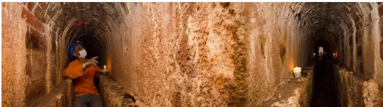
Foto 6. Túneles en ladrillo que rodean el desarenadero – Canal de descarga de fondo del sistema de tanque de decantación.
