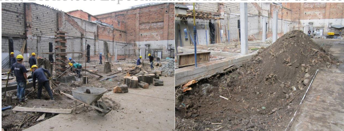
Fotos 59 y 60. Proceso de adecuación de los sectores donde se iban desmontando especies botánicas. Derecha: Acopio de lleno antrópico y tierra que se extendía sobre la zona donde se encontraba ubicada anteriormente una de las jardineras del sector 1. Izquierda: Excavación manual para adecuación y nivelación del sector 1.
