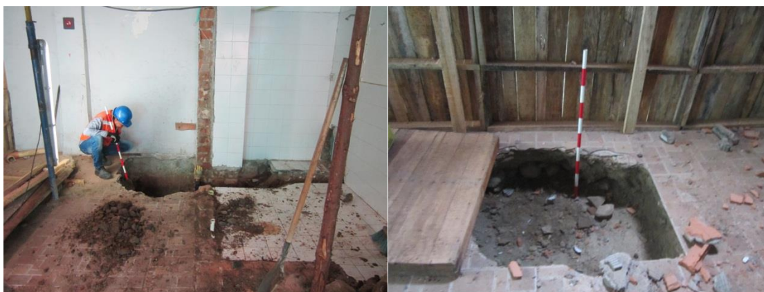
Fotos 75 y 76. Excavaciones manuales de nichos para zapatas y brechas para instalación de redes de alcantarillado Sector 2, Sub-sector B.
