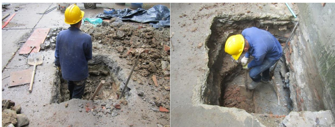
Fotos 73 y 74. Excavaciones manuales para nichos de zapatas Sector 2 - Sub-sector A.
