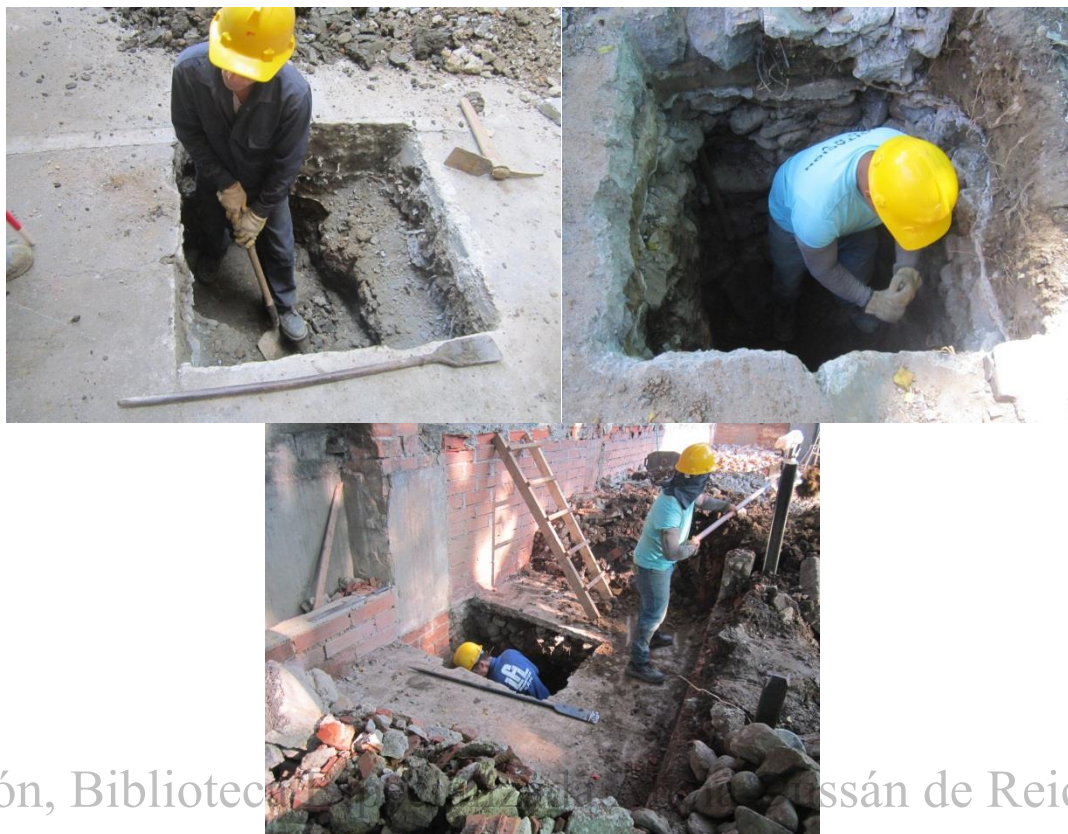
Fotos 85, 86 y 87. Acompañamiento arqueológico a actividades de excavación manual de nichos de zapatas con barra y pala, Sector 2 sub-sector A.
