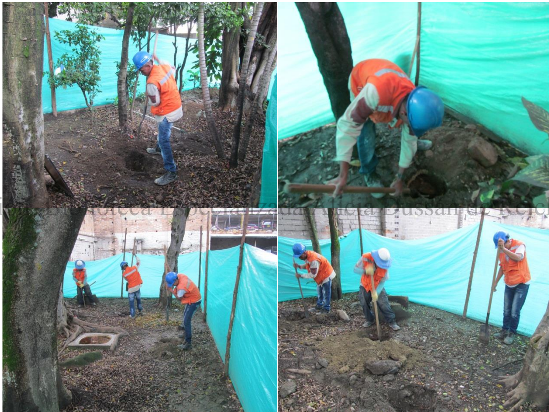
Fotos 40, 41, 42 y 43. Elaboración de pozos de sondeo por parte de auxiliares de campo en las zonas de las jardineras 1, 2 y 4 respectivamente.
