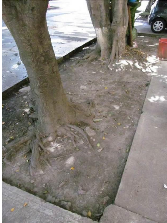
Foto 37. Detalle de jardinera sector 1, donde se aprecian las raíces superficiales de los árboles de laurel, los cuales según el tamaño de su tronco se pueden estimar entre 20 y 30 años de edad.
