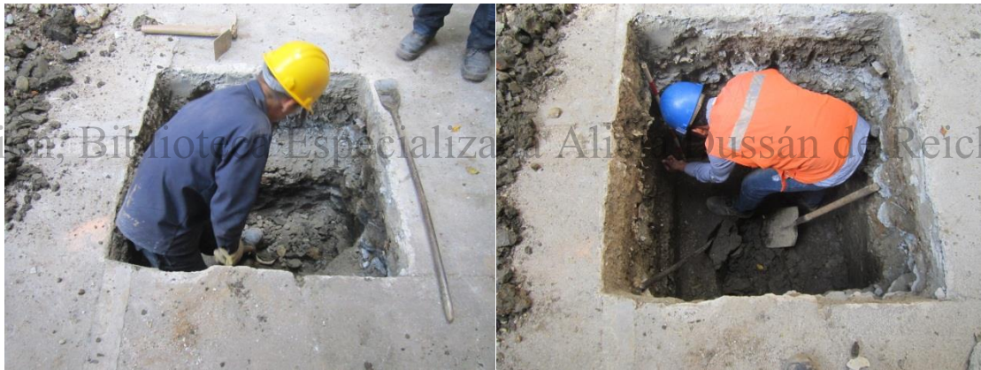
Fotos 30 y 31. Labores de monitoreo en excavaciones manuales para zapatas. Izquierda: Acompañamiento arqueológico a excavación manual para nichos de zapatas. Derecha: Revisión de perfiles visibles tras excavación manual, sin reporte de hallazgos.
