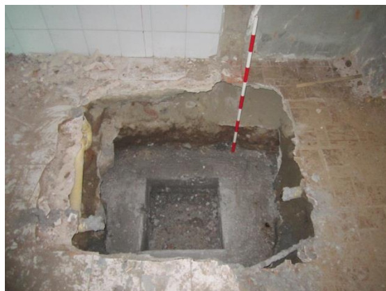
Foto 95. Registro de pared contigua al perfil estratigráfico descrito en el párrafo anterior durante la fase de vaciado de nichos para zapatas Sector 2, sub-sector B luego de realizada la excavación manual.
