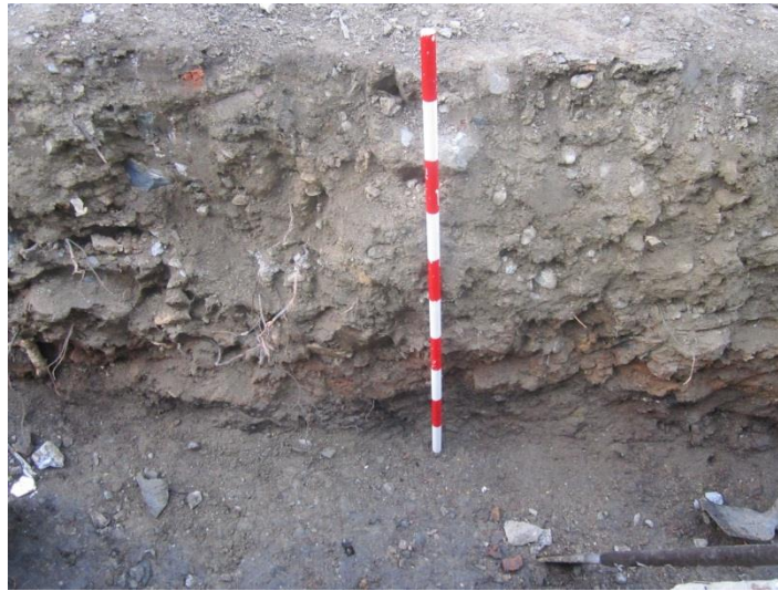
Foto 71. Perfil estratigráfico expuesto luego de excavación manual de brechas para la instalación de redes de alcantarillado, en el que se observan dos capas de llenos artificiales compactados, producto de actividades antrópicas previas en la zona.
