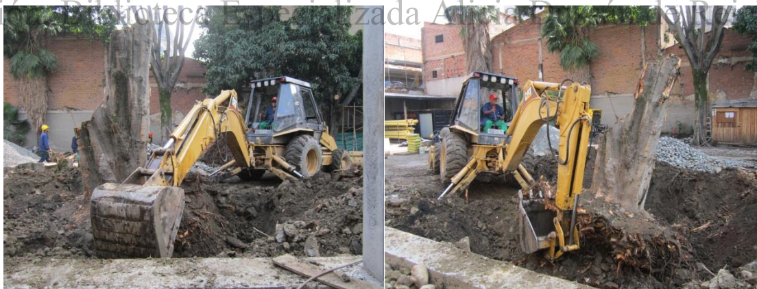
Fotos 20 y 21. Fase de excavación con maquinaria en una de las jardineras del sector 1. Derecha: Desmonte de árbol de laurel utilizando maquinaria pesada (retrocargadora). Izquierda: Excavación con retrocargadora para proceder al desmonte de árboles.
