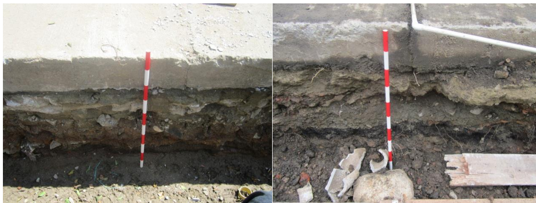
Foto 78. Revisión de material desalojado simultáneo a excavación manual de brechas para instalación de redes de gas, eléctricas e hidro-sanitarias, Sector 2 sub-sector A.
