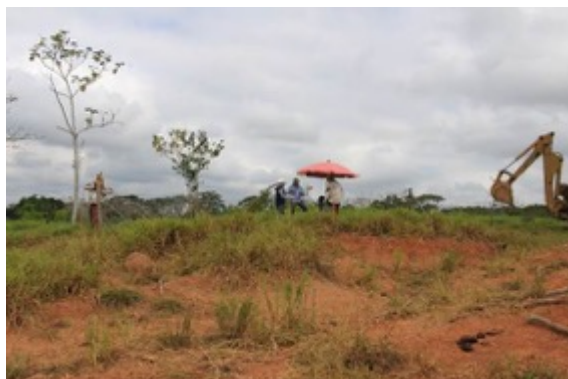
Fotografía 4-173 Panorámica sitio de torre # 40
