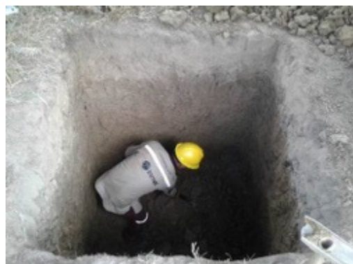
Fotografía 4-49 Actividades de monitoreo excavación Torre # 4
