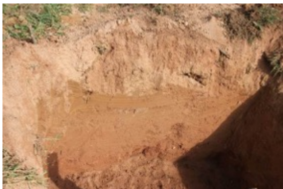
Fotografía 4-254 Profundidad final sitio de torre # 68
