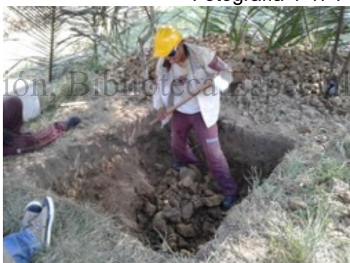
Fotografía 4-48 Actividades de monitoreo excavación Torre # 4
