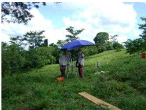
Fotografía 4-282 Panorámica sitio de torre # 77
