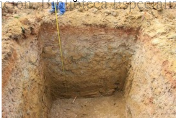
Fotografía 4-277 Profundidad final sitio de torre # 75
