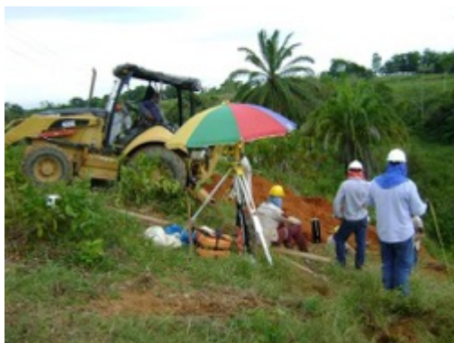
Fotografía 4-183 Panorámica sitio de torre # 43
