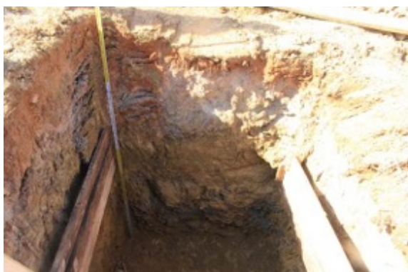
Fotografía 4-121 Profundidad final sitio de torre # 24
