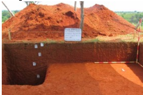
Fotografía 4-22 Perfil Sur Corte Torre 12
