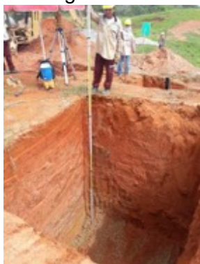
Fotografía 4-224 Profundidad final sitio de torre # 56
