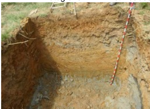
Fotografía 4-242 Profundidad final sitio de torre # 64
