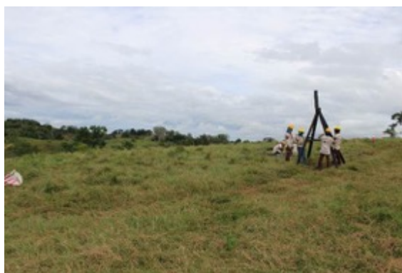
Fotografía 4-83 Panorámica sitio de torre # 13
