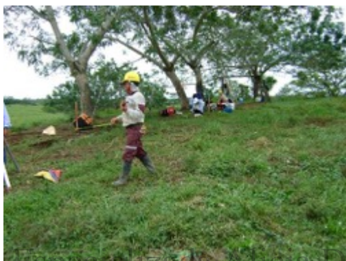
Fotografía 4-104 Panorámica sitio de torre # 20
