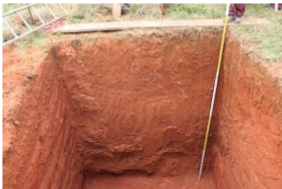
Fotografía 4-86 Profundidad final sitio de torre # 13
