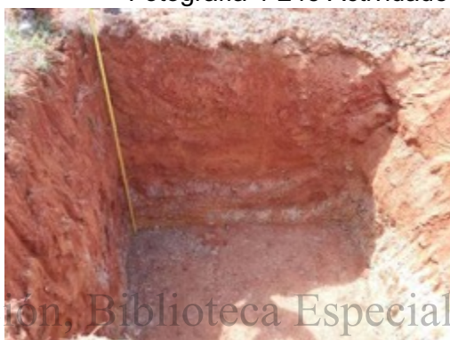
Fotografía 4-246 Profundidad final sitio de torre # 65
