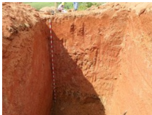
Fotografía 4-213 Profundidad final sitio de torre # 52
