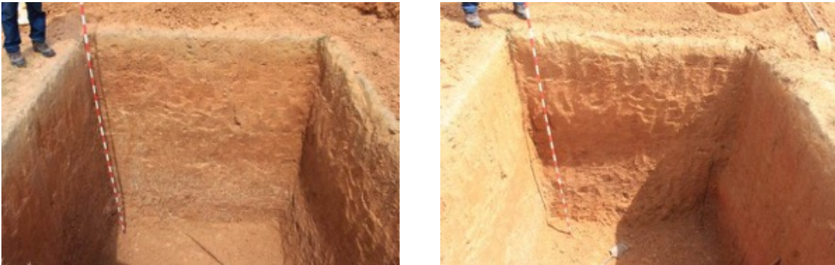
Fotografía 4-91 Profundidad final sitio de torre # 15
