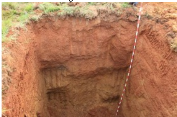
Fotografía 4-168 Profundidad final sitio de torre # 38
