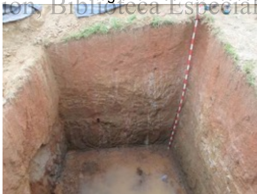
Fotografía 4-100 Profundidad final sitio de torre # 18
