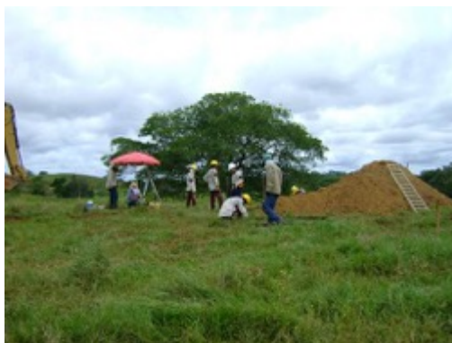
Fotografía 4-87 Panorámica sitio de torre # 14
