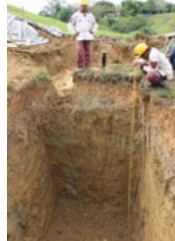
Fotografía 4-215 Profundidad final sitio de torre # 53
