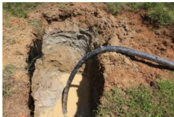
Fotografía 4-210 Profundidad final sitio de torre # 51
