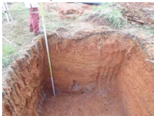
Fotografía 4-166 Profundidad final sitio de torre # 37
