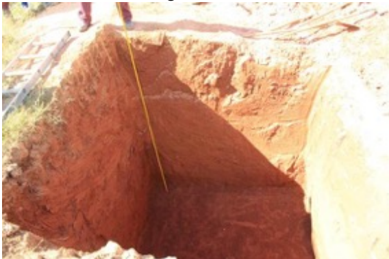
Fotografía 4-74 Profundidad final sitio de torre # 10
