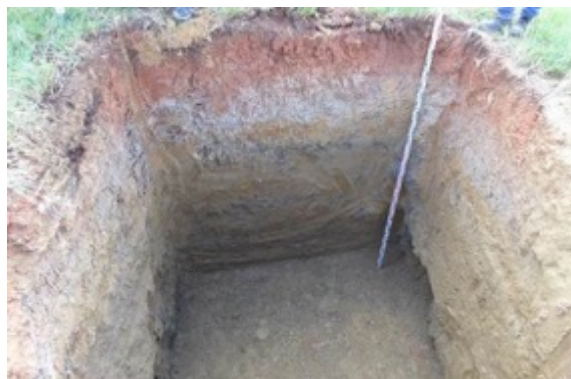
Fotografía 4-267 Profundidad final sitio de torre # 72
