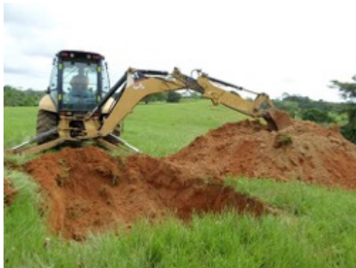
Fotografía 4-204 Panorámica sitio de torre # 50
