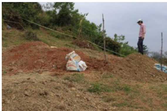
Fotografía 4-44 Panorámica sitio de torre # 3
