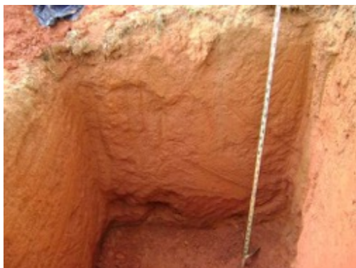
Fotografía 4-78 Profundidad final sitio de torre # 11
