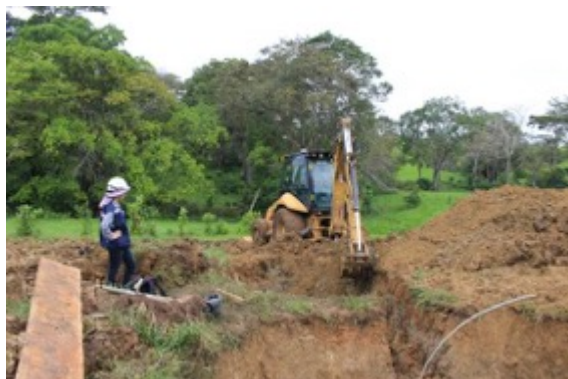
Fotografía 4-214 Actividades de monitoreo excavación Torre # 53
