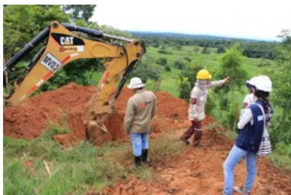
Fotografía 4-268 Actividades de monitoreo excavación Torre # 73
