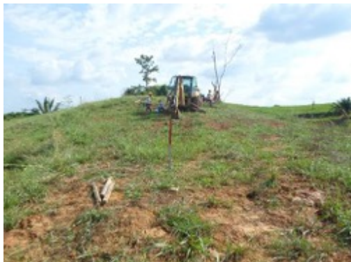
Fotografía 4-243 Panorámica sitio de torre # 65
