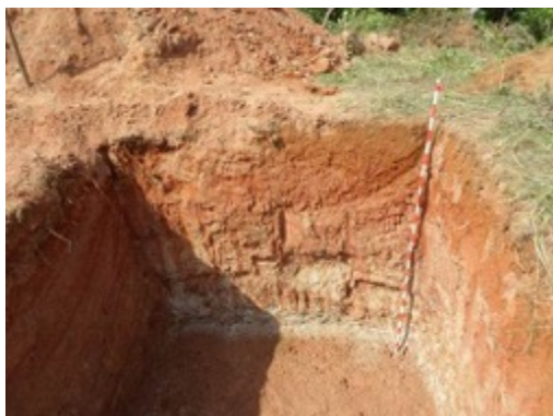
Fotografía 4-201 Profundidad final sitio de torre # 48
