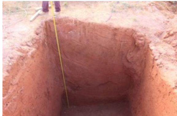
Fotografía 4-74 Profundidad final sitio de torre # 10
