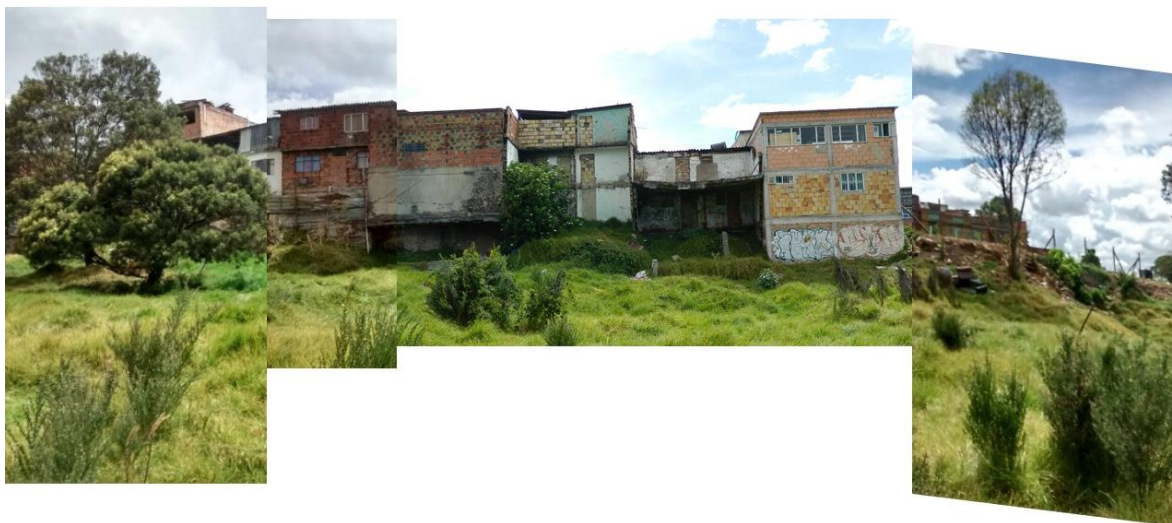
Figura 16 Construcciones del margen sur del polígono del proyecto Monte Rizzo.
