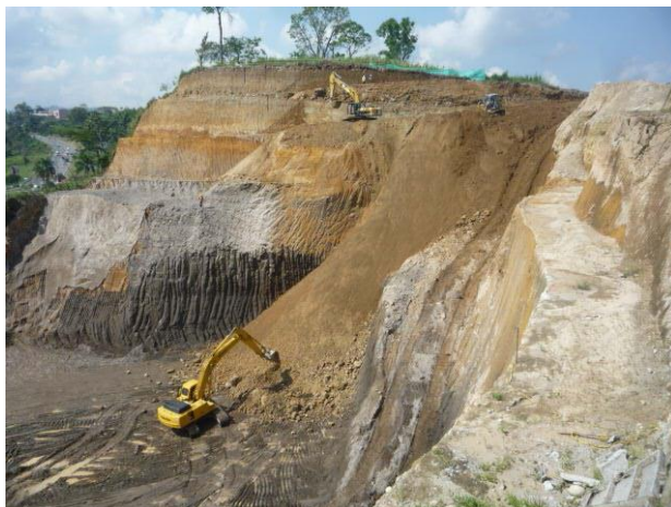
Fotografía 4 Proyecto Vial Variante La Paz, predio El Edén, Nótese el corte de máquina de unos 35m aproximadamente
